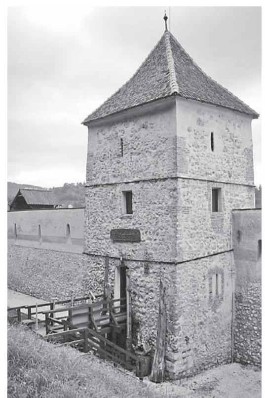
In die renovierten Türme der Stadtmauer unterhalb der Zinne sind Handwerker und Künstler eingezogen. Im Turm auf dem Foto zeigt ein Holzschnitzer die Ergebnisse seiner Arbeit
