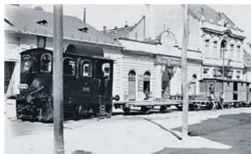
Trambahn in der oberen Langgasse.
