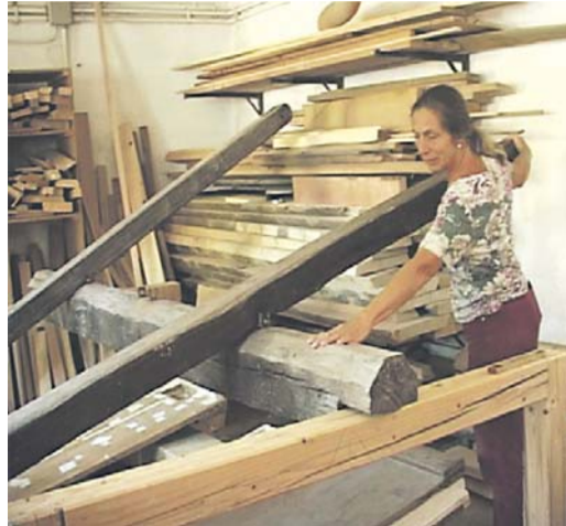
In der Werkstatt werden morsche Teile ausgetauscht und ersetzt.
