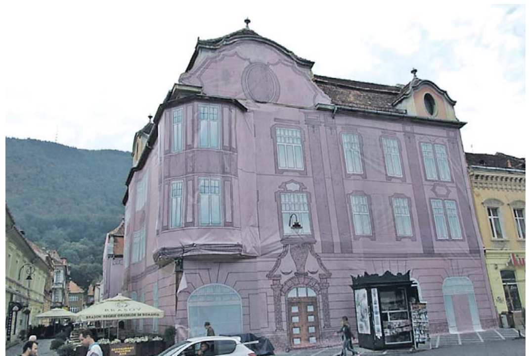
Die umhüllte Fassade des Gebäudes.
