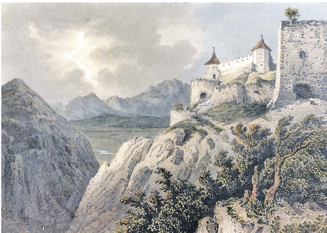
Die Rosenauer Burg (Teilansicht) auf einem Stahlstich des Nürnbergers Ludwig Rohbock (1854).
