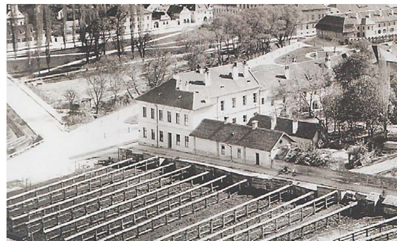
Blick auf das unbebaute Grundstück am Raupenberg.
