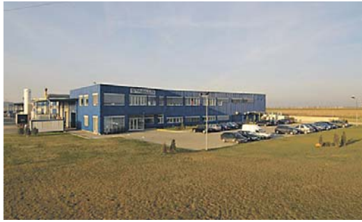
Das Produktionsanlage von Stabilus.
