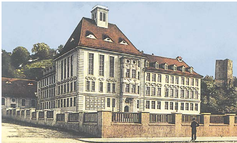
Die neu errichtete „Neue Honterusschule“.
