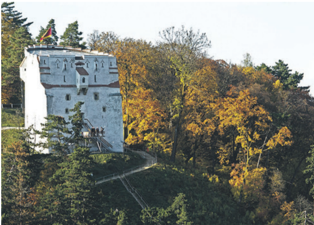
Der „Weiße Turm“ mit seinem neueren Glas-Schrägdach. Der Turm beherbergt seit einigen Jahren ein Museum. Aufgenommen von der Grabtastei, von der eine Treppe zum Turm führt. Foto: Peter Simon
