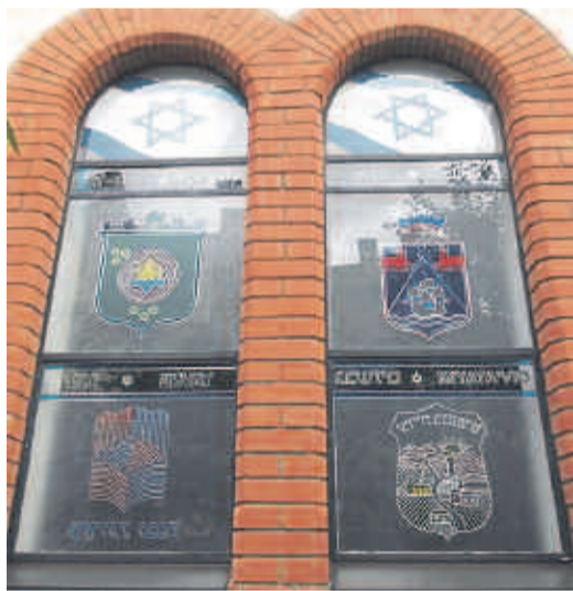
Die neuen Fenster der Synagoge.
