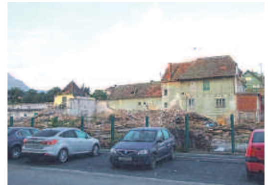
Nach dem Abriss ist das alte Gebäude wieder sichtbar.
