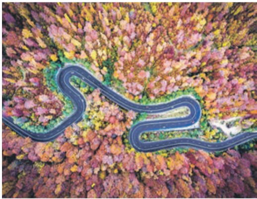
Blick auf den Geisterwald „padurea-bogata“. Drohnfoto: Calin Andrei Stan, 2016
