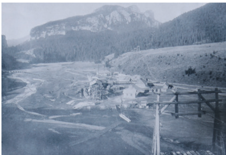
Papierfabrik Bolboci, Antrieb und Beladestation der Drahtseilbahn.
