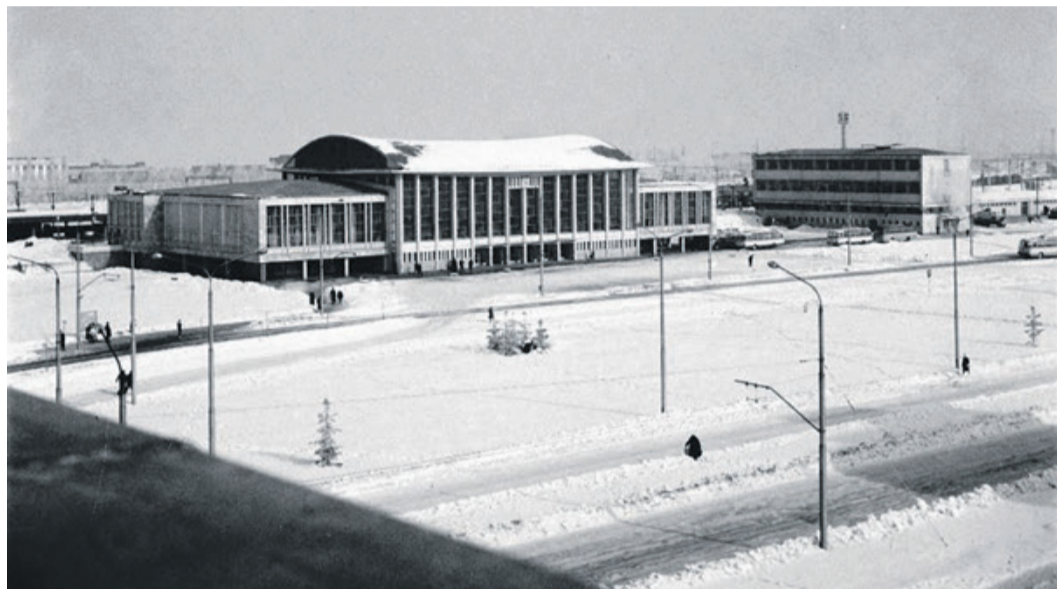
Der neue Bahnhof im Winter 1963/64, als es noch kein angelegtes Straßennetz vor dem Bahnhofsgebäude gab, sondern nur den erweiterten und ausgebauten ehemaligen Bahndamm, auf dem bis 1965 der einzige Zugang erfolgte.
