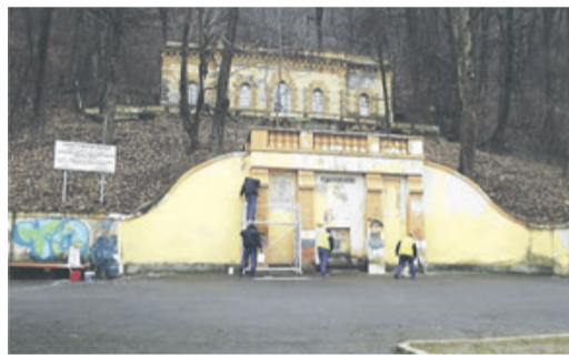
Die Reinigung und Renovierung hat begonnen.
