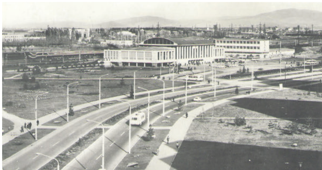
Kronstädter Bahnhof um 1970 mit noch unvollständigem Straßennetz.
