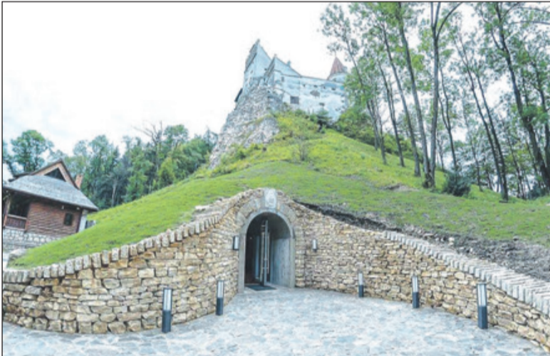
Der neu ausgebaute Garteneingang in die Törzburg.
