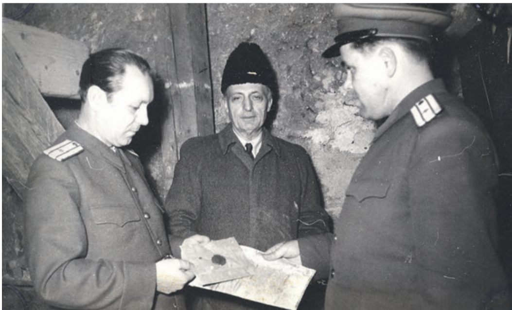
Dr. Konrad Möckel 1958 in Begleitung von Securitate-Offizieren im Dachstuhl der Oberen Sakristei der Schwarzen Kirche bei der Freilegung des Protestschreibens des Presbyteriums der Honterusgemeinde gegen die Enteignung der neuen Honterusschule (Prozessakten im Archiv des CNSAS).
