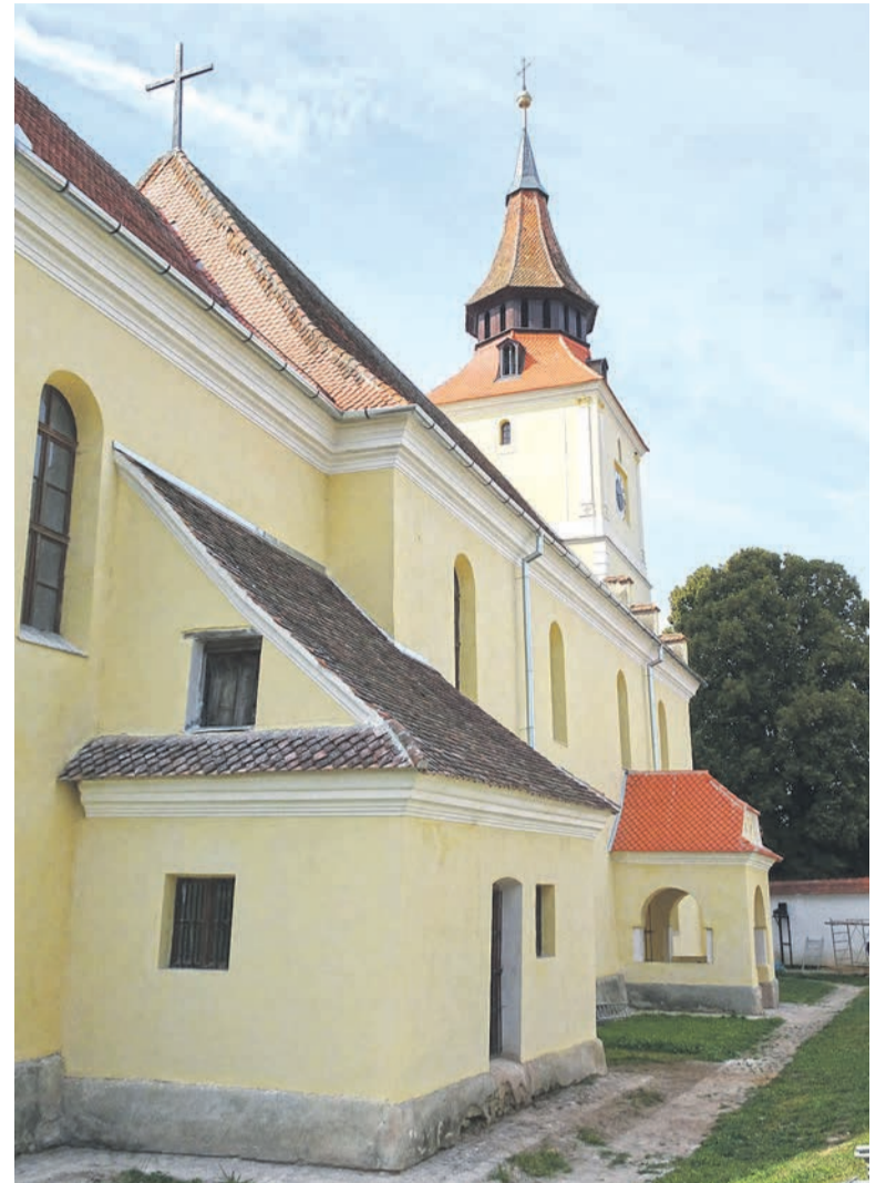
Die evangelische Kirche in Brenndorf erstrahlt nun rundum in neuem Glanz, nachdem im Sommer 2019 die Nordseite des Gotteshauses renoviert wurde.
