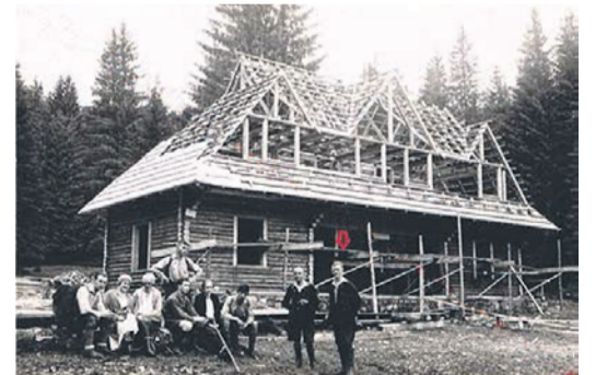
Karl Lehmann vor der im Bau befindlichen Berg-Hütte.
