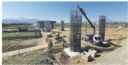
Die Pylonen einer zukünftigen Brücke der Autobahn.
