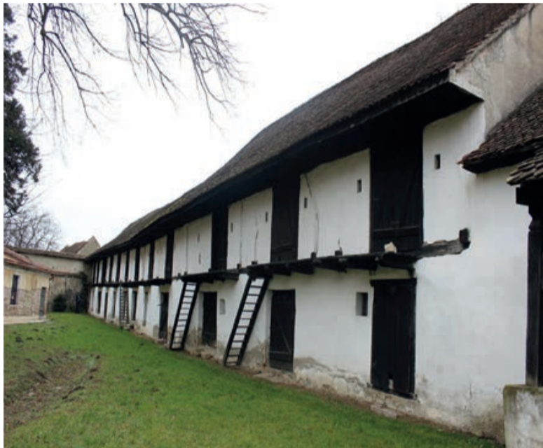
Die noch vorhandenen Vorratskammern in der Wehrmauer.
