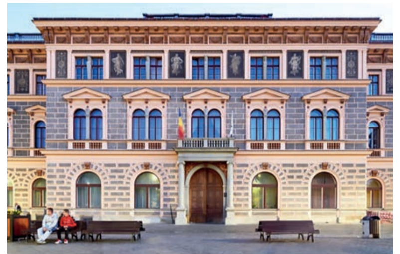
Das renovierte Gebäude beherbergt das Rektorat der Universität „Transilvania“.
