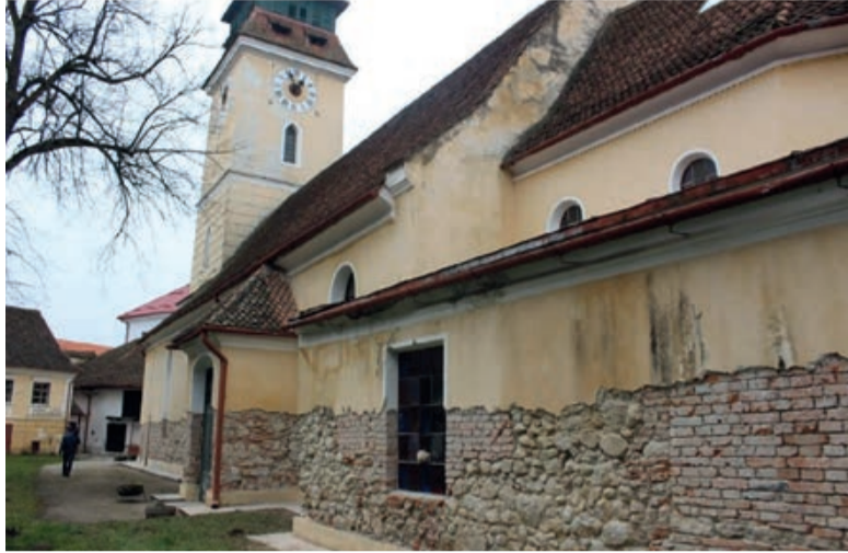
Die Renovierung hat begonnen, der Grundputz wurde schon entfernt.
