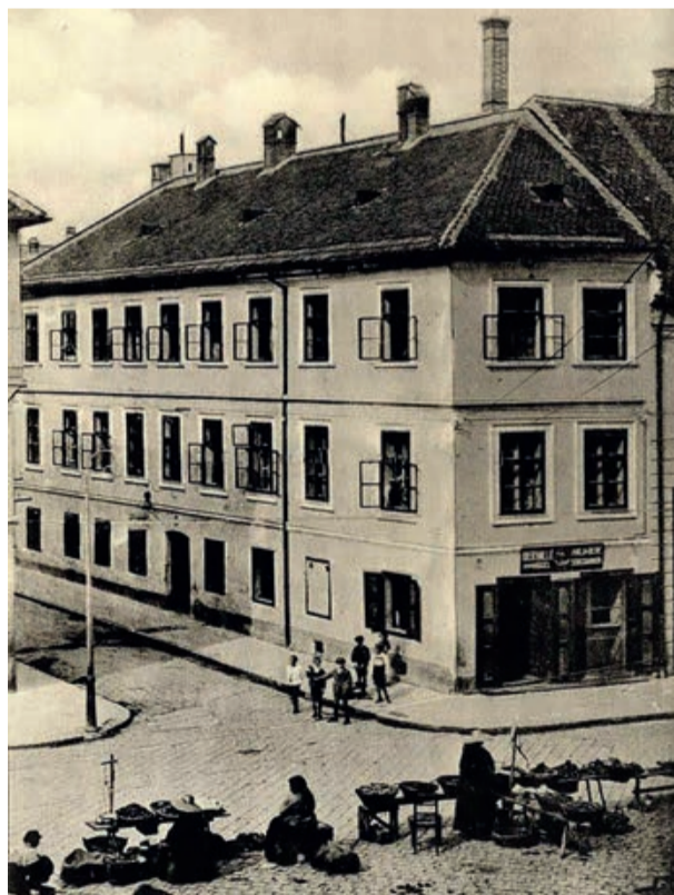
Das Haus am Kotzenmarkt 150, Ecke Hirschergasse-Neugasse. Im Parterre war das Restaurant Hügel.
