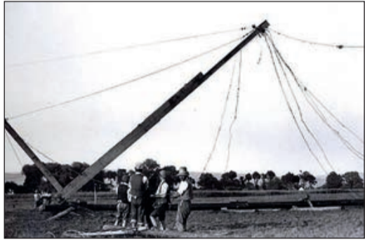
Aufstellen der ersten provisorischen Sendemasten aus Holz. Quelle: Valer Literat 2016
