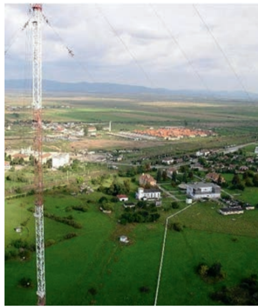
Die Gebäude der Sendeanstalt von einem der Funkmasten aus gesehen.
