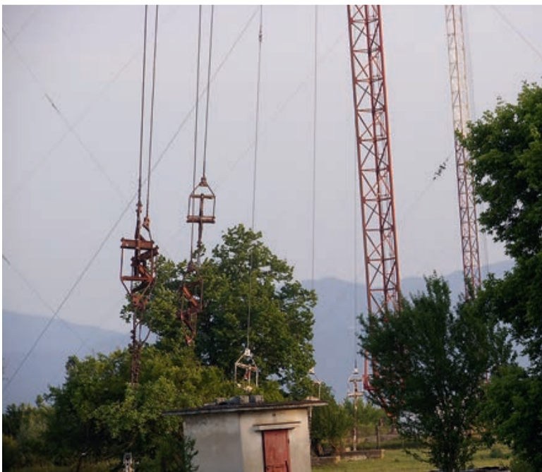
Detail: Verankerung der Stahlseile. Die Sendemasten stehen auf großen Betonkugeln und werden mit Stahlseilen verankert. Innerhalb der Masten sind Leiterspinnen, die für Wartungsarbeiten dienen.
