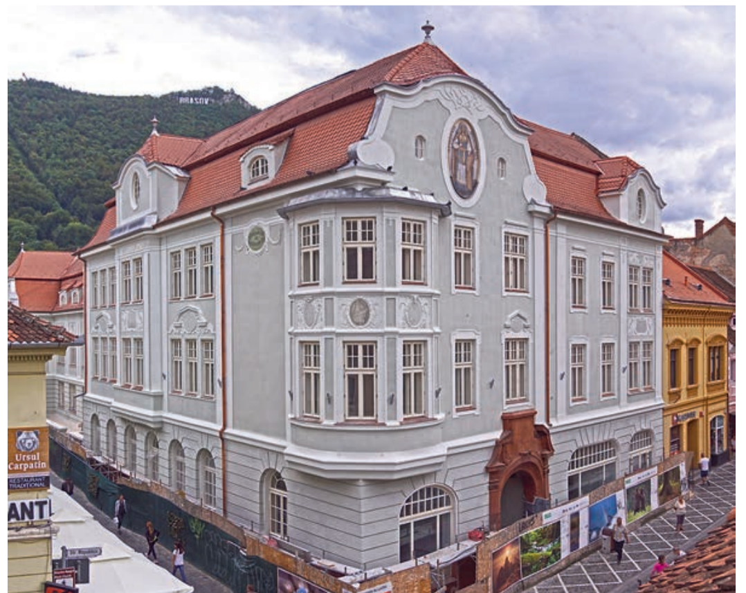
Heutiger Zustand nach der Renovierungsaktion. Der hellgrüne Farbanstrich der Fassade lässt das Prunkportal besser zur Geltung kommen. Foto: Peter Simon, Aufnahme vom 1. September 2022
