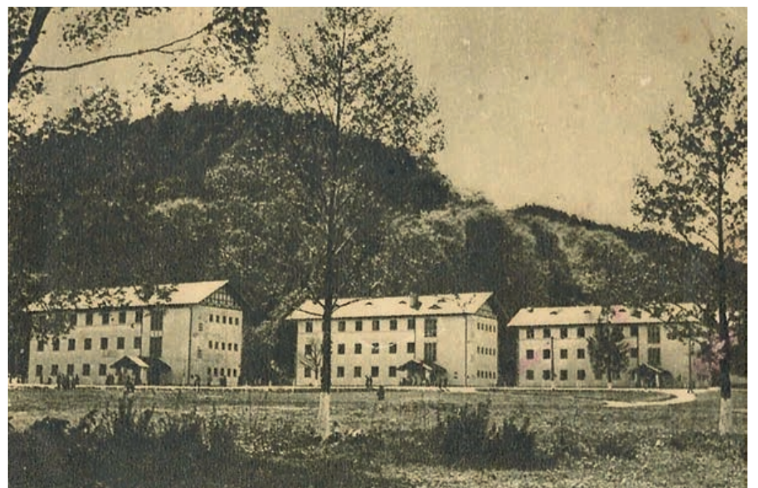
Drei der acht erwähnten Blocks der Anlage.
