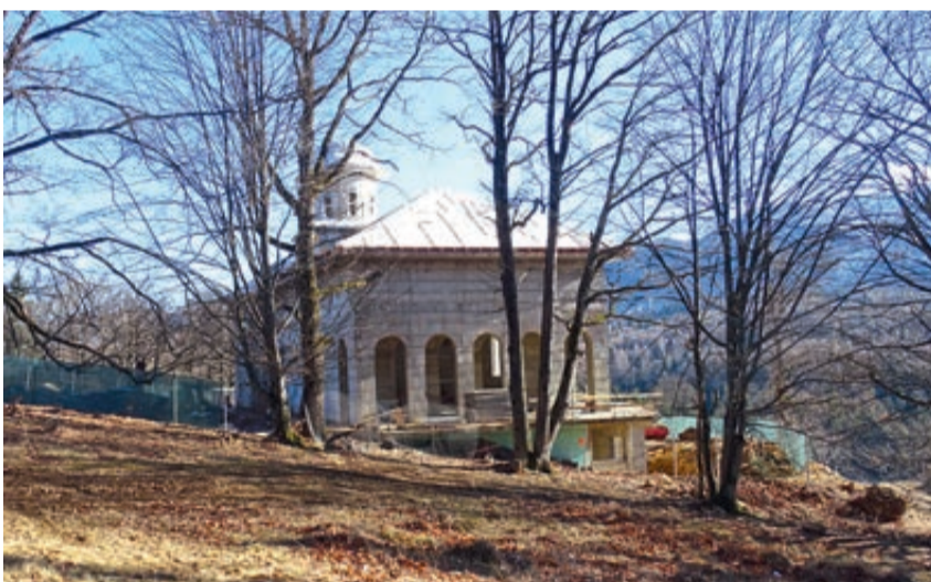
Baustelle auf dem Langen Rücken in der Schulerau: In der Nähe der Wiese, wo die Honterusfeste stattfinden, entsteht eine griechisch-katholische Kapelle.
