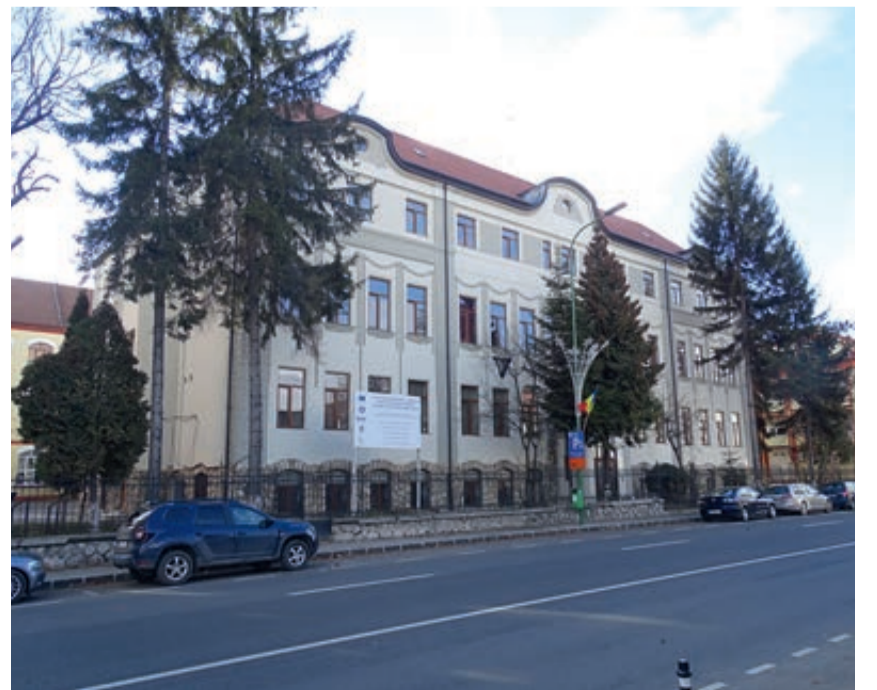
Das Gebäude der ehemaligen Königlich-Ungarischen Staats-Gewerbeschule für Holzverarbeitung in Kronstadt, Bahnstraße/Iuliu-Maniu-Straße 52, beherbergt heute das Technische Kolleg „Transilvania“ Foto: der Verfasser
