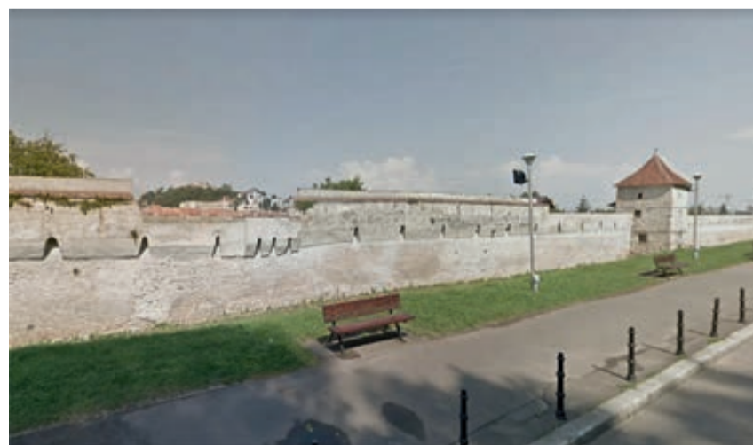
Die renovierungsbedürftige Stadtmauer.
