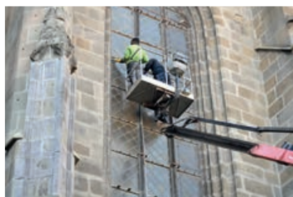
Fachhandwerker reparieren die Fenster Foto: der Verfasser
