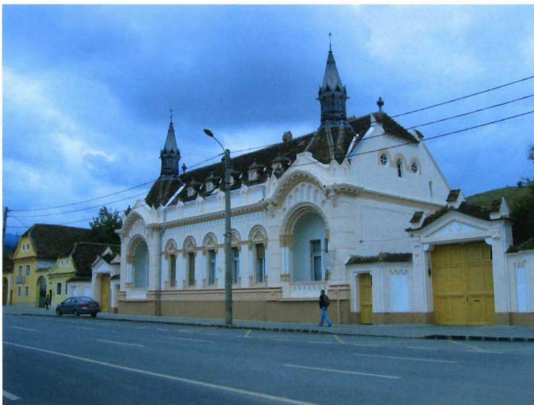
Renovierte Fassaden des Pfarrhauses, des Kirchendiener- und Predigerhauses (Foto: K. Boltres 2008)
