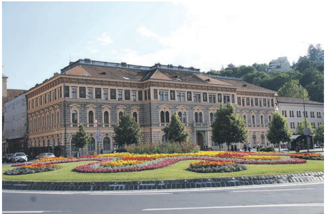
Die Pensionsanstalt, heute Rektorat der Kronstädter Universität. Sie wurde in den Jahren 1881-1884, nach Plänen des damaligen Stadtarchitekten Peter Bartesch (1842-1914), in den ehemaligen Kürschnerzwinger, im Stil der Neurenaissance, gebaut. Peter Bartesch hatte ein Jahr vorher den Bebauungsplan für die „Neue Straße“, später Rudolfsring benannt, entworfen. Wenige Jahre später wurde die Riemerbastei, die nord-östlichste Kronstadts, abgeräumt und an ihre Stelle, ebenfalls nach Plänen von Peter Bartesch, eine Villa für den Großkaufmann Manole Diamandi, Präsident der Handels- und Gewerbekammer, gebaut. Heute trägt sie den Namen Villa Baiulescu, nach seinem Schwiegersohn, und ist Teil der Kreisbibliothek. Das Gebäude der Pensionsanstalt hat im Laufe der Jahre mehrere städtische Institutionen beherbergt wie Komitat, Präfektur, Post usw. Im Erdgeschoss war das anspruchsvolle Café Transilvania, bis zum Jahr 1950, untergebracht. Zwischen den Fenstern des zweiten Stockes gibt es allegorische Bilder im Sgraffito-Stil gezeichnet. Man schreibt sie der Künstlerin Lotte Goldschmidt zu, sie wurden aber vermutlich eher von ihrem Vater Ludwig Goldschmidt realisiert. Die große Renovierungsaktion von 2020 wurde vom Architekt Edmund Olsefszky betreut. Foto/Text: Peter Simon
